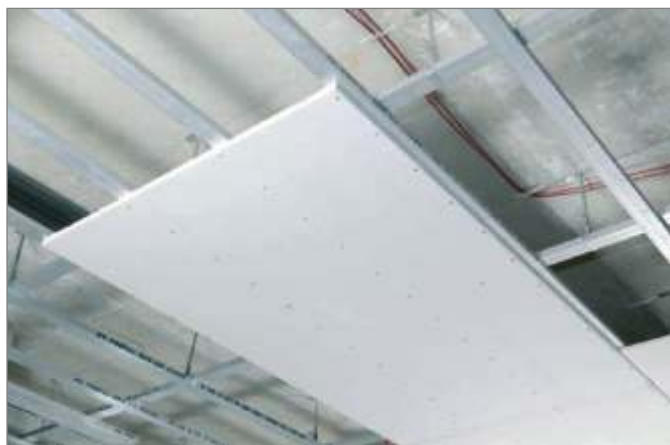
Imag. 8-5 elemente de tavan montate
