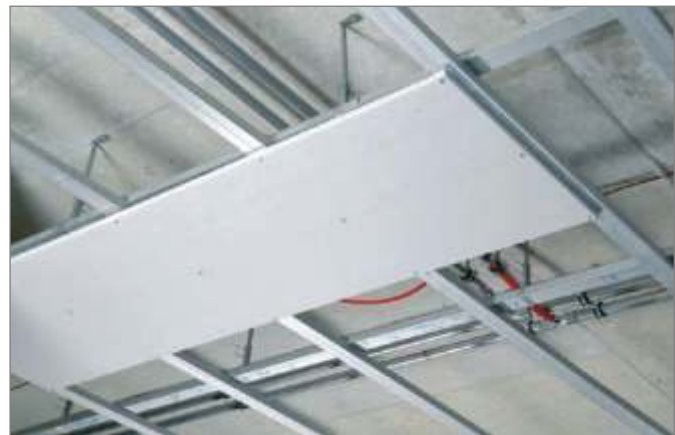
Abb. 9-5 Montarea elementelor de perete la tavan
